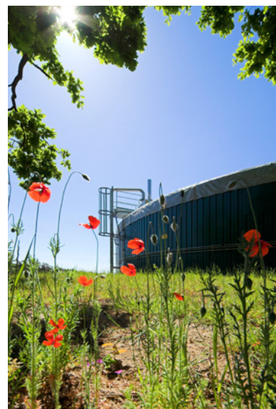
BGA Gut Borken: Helios® Biogasanlage
